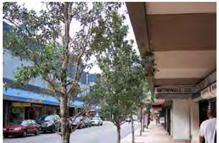
Figure 1.- Mal diseño, árboles grandes demasiado cerca del edificio. Foto cortesía de H. Mayer.
