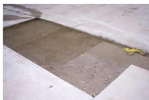
Figura 2.- Suelo compactado en un entorno urbano, cortesía de H. Mayer
